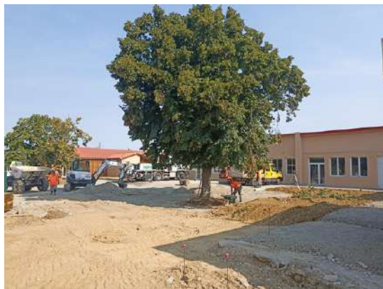
désimperméabilisation de la cour de récréation - fin juillet
